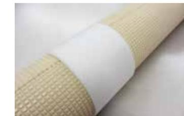
必ず、保温材接続専用テープを使用すること!
