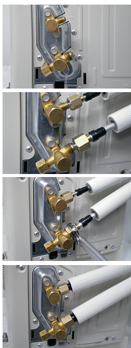
アルミ管フレア加工
